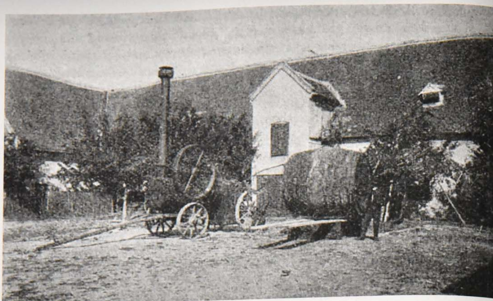
14. kép Az új hordókat a lokomobilra kapcsolva kigőzölték Szilárd Gyulának a Borászati Lapok hasábjain 1902-ben megjelent cikksorozata illusztrációiból ( Borászati Lapok , 1902. A következő oldalakon: 604–606., 617–618., 635–636., 652–653., 674–676.)
